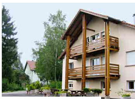
Le bâtiment dit «La ferme» au Bercaïl.
